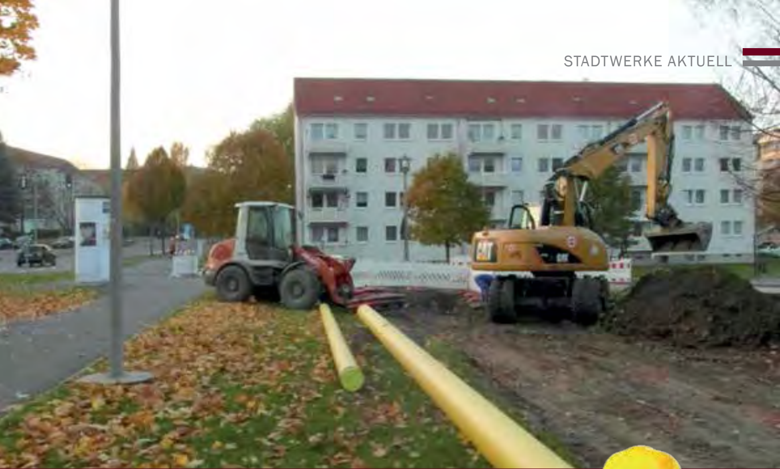
Erneuerung der Gashochdruckleitung Kreuzung Karl-Kegel-Straße – Albert-Einstein-Straße
