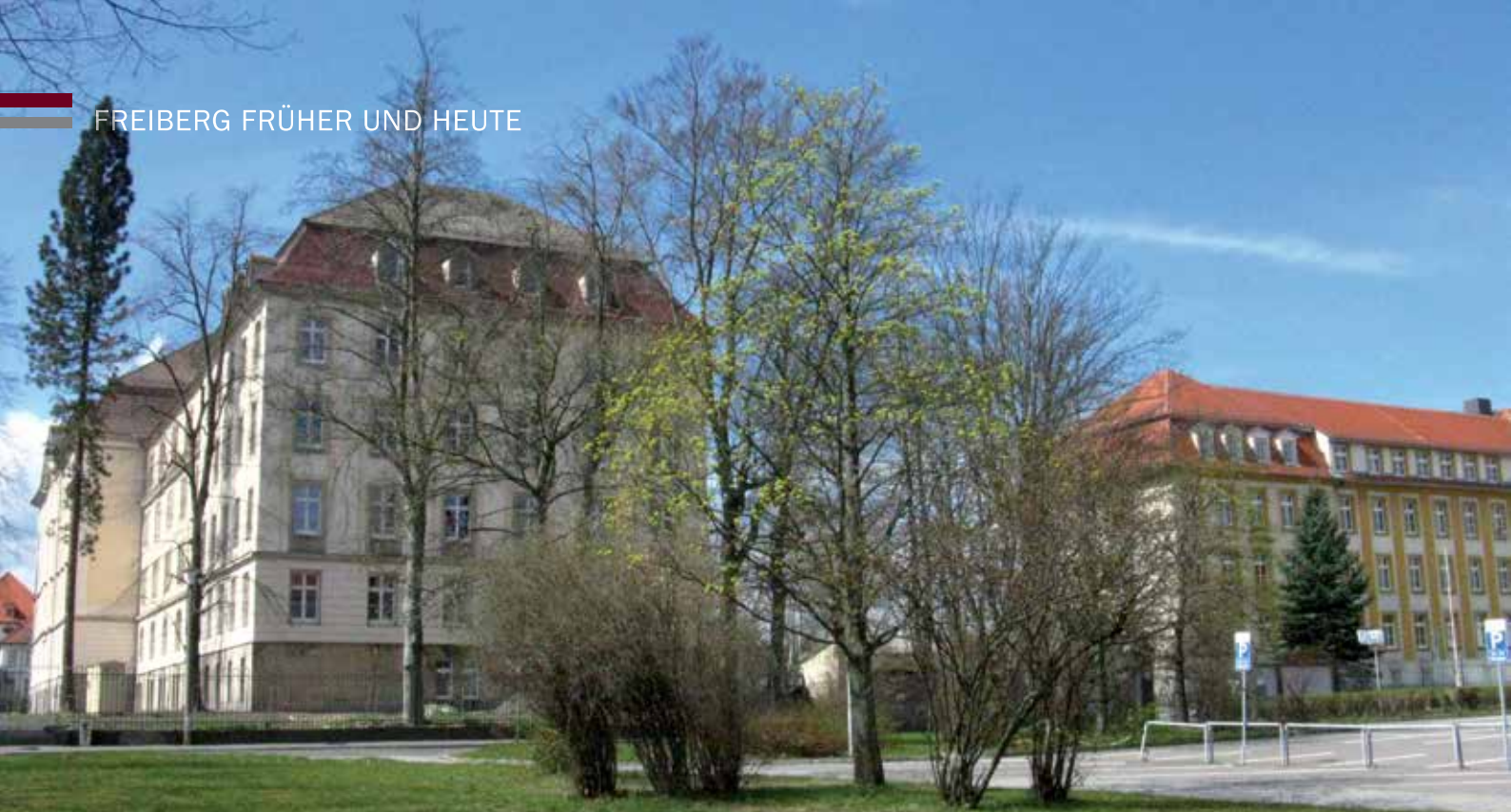
Der Gebäudekomplex nach umfangreicher Sanierung.
