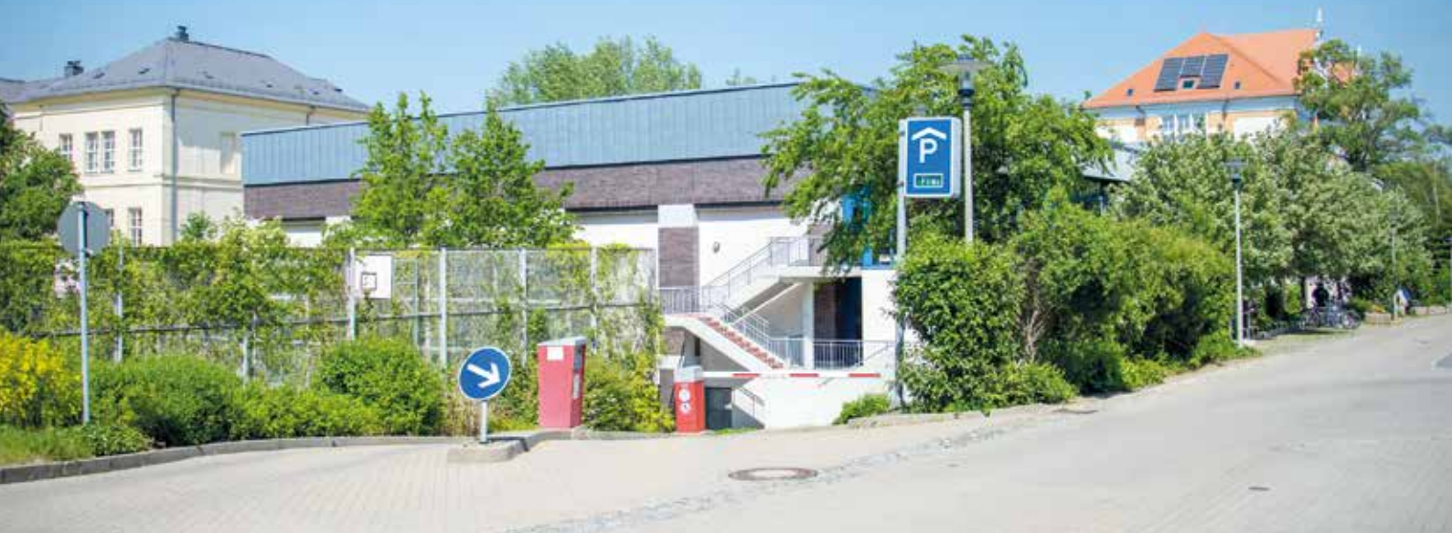
Die Heizzentrale des Schulkomplexes befindet sich in der Heubner-Sporthalle.
