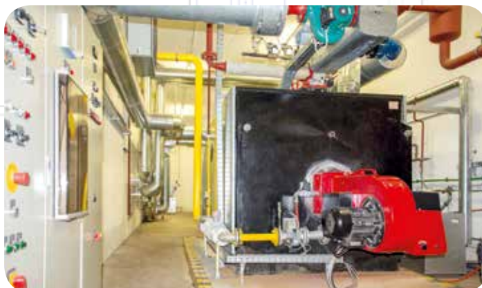
Ein Blick in den Heizraum: Der Niedertemperatur-Gaskessel mit einer Wärmeleistung von 2.000 kW wird demontiert.
