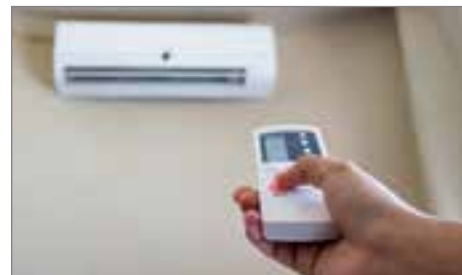
Elektrische Klimaanlagen entziehen der Raumluft Wärme nach dem Kühlschranksprinzip.
