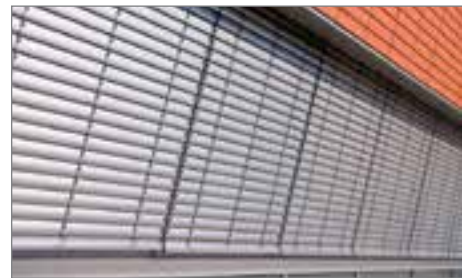
Ein Sonnenschutz verhindert das übermäßige Aufheizen von sonnenseitigen Räumen.
