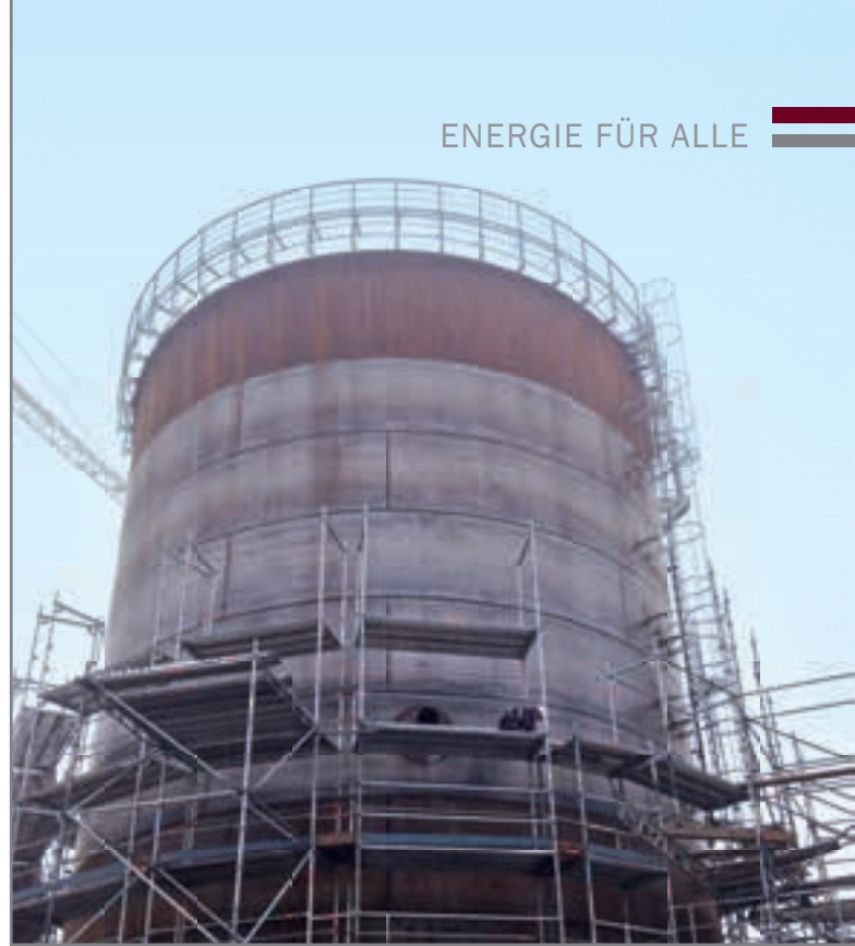
Unser Heizkraftwerk im Umbau 2013
