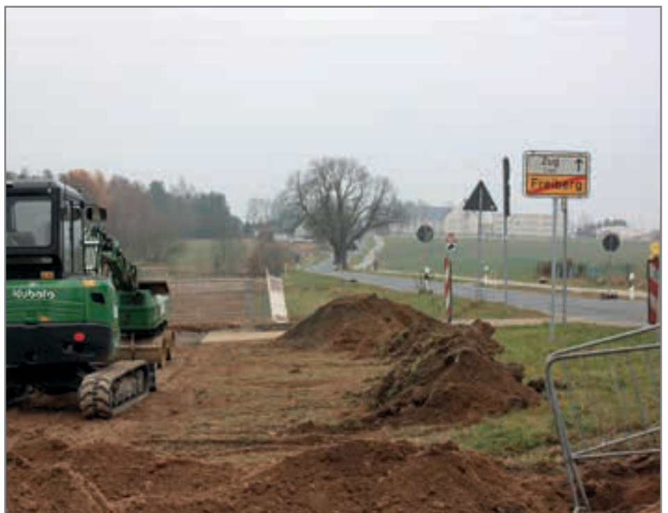
Bauarbeiten im Herbst 2012
