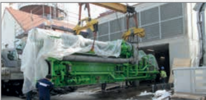
Einbringung der neuen Motoren
