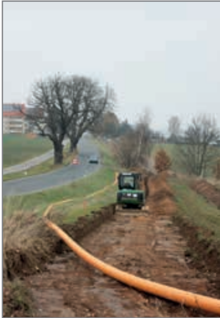
Verlegung der neuen Versorgungsstrasse
