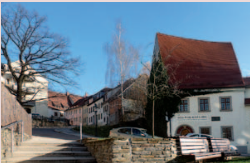
Das Eckgebäude Wasserturm- straße/Ecke Berg- gasse heute.
