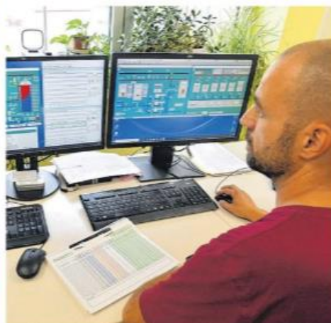
Im Heizkraftwerk an der Chemnitz Straße überwacht Betriebselektriker André Naumann auch die Vorlauftemperaturen. Jedes Grad weniger bedeutet geringere Übertragungsverluste. FOTOS: EDUARD WILKNER (2)
