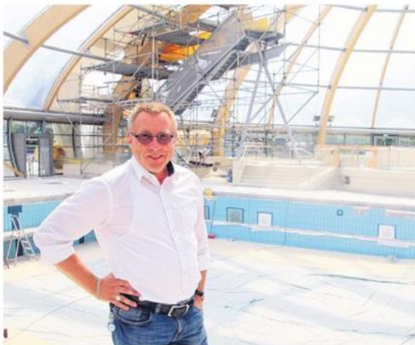
Stadtwerkechef Axel Schneegans in der Schwimmhalle des Freiburger Johannisbades, wo gerade die Bauleute das Sagen haben. Anfang September sollen die Arbeiten abgeschlossen werden. FOTOS: WELAND/JOSCH/2
