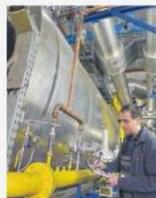
Das Heizkraftwerk Chemnitz-Strasse, hier mit Kirill Wasow, speist ein 28 Kilometer langes Fernwärmenetz.
